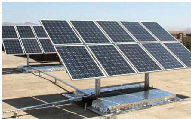
سازه سقف خانه
